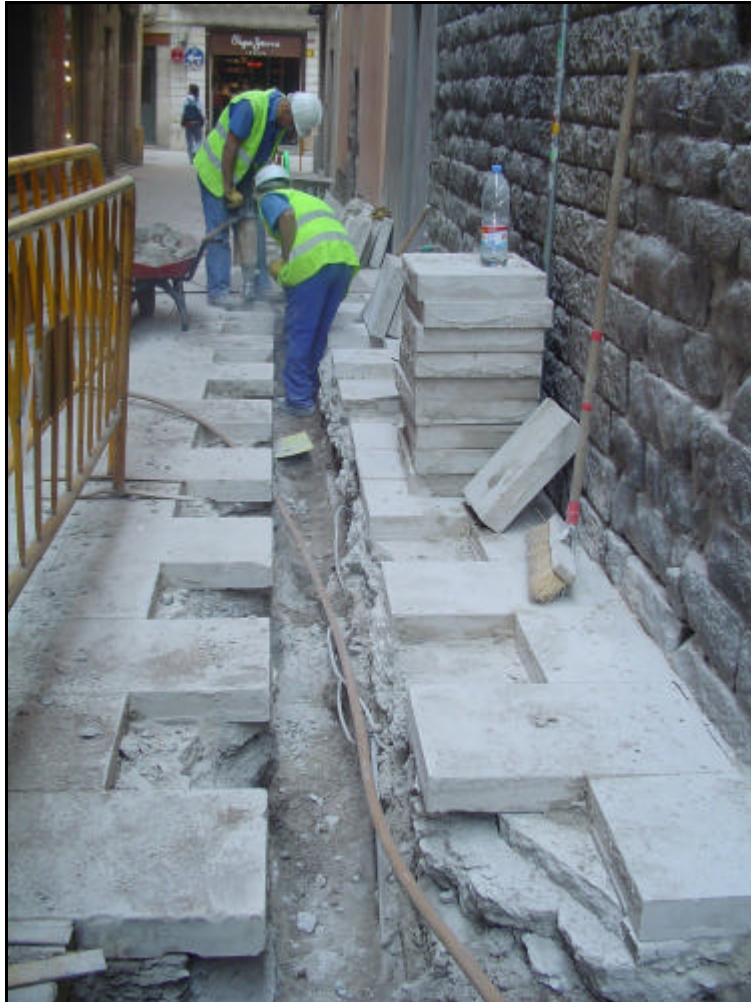
Foto 4: Treballs constructius al carrer dels Sombrerers.
